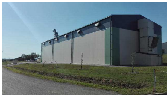
Vue sur les bâtiments depuis le nord
