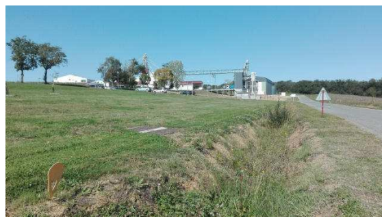
Vue sur les terrains de l'extension depuis le sud-est
